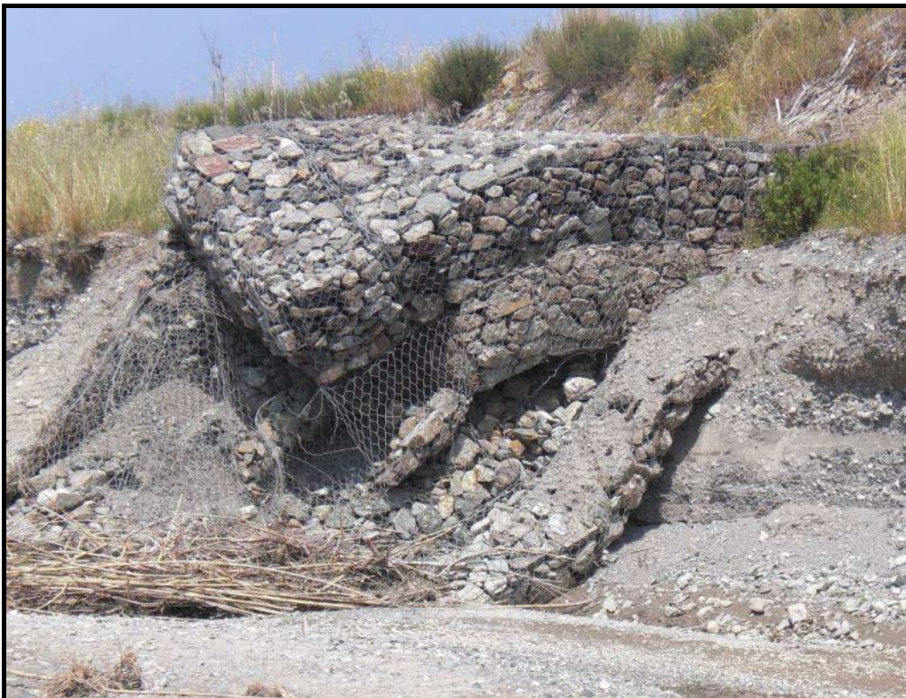
Opere di arginature e protezione di sponda.
