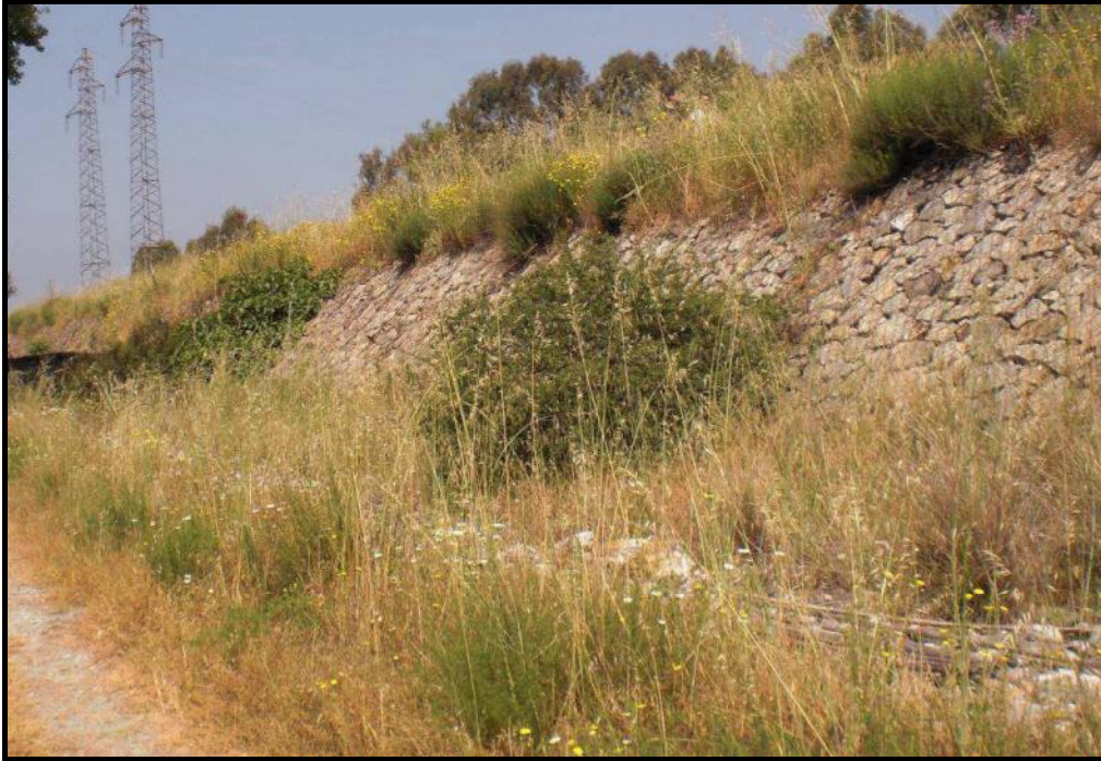
Opere di arginature e protezione di sponda.
